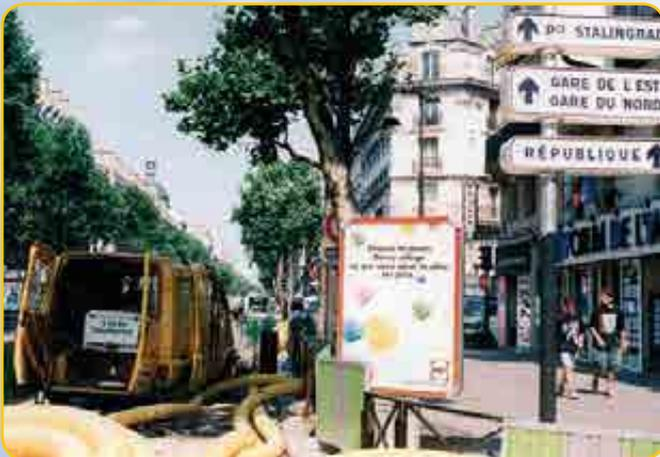
Dieselschweißaggregat eingebaut in einen Montagewagen für Stadtbaustellen Gaswerke Paris
