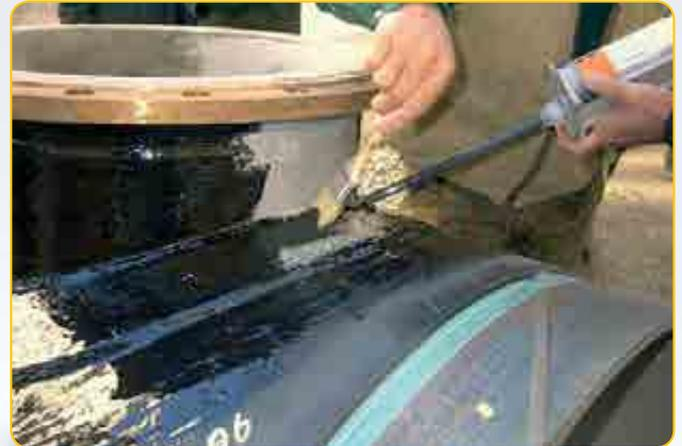
Formteilbeschichtung mit Polyurethan-Streichbeschichtung
