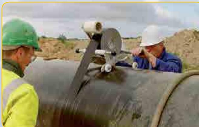
Nachisolierung von Schweißverbindungen auch an großen Rohrdurchmessern
