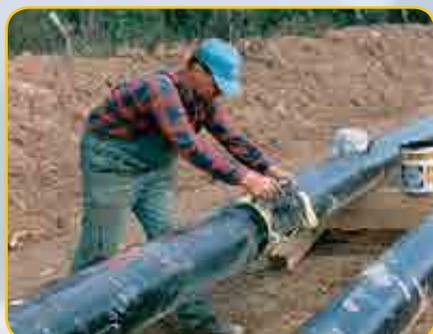
Nachisolierung von Schweißverbindungen mit kaltverarbeitbaren Kunststoffbändern
