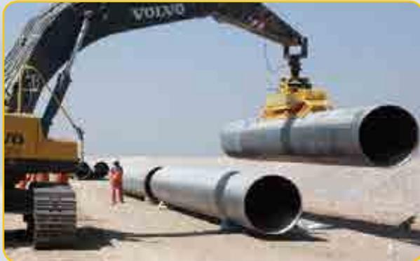
VACUVIETZ im Baggereinsatz mit hydraulischem Drehkopf
