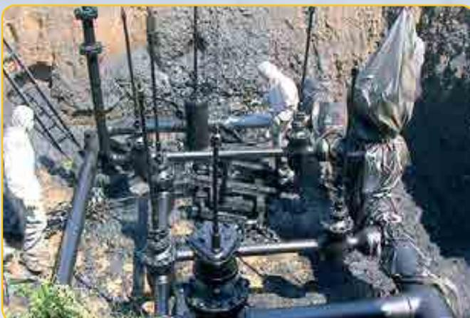
Umhüllungssanierung komplexer Bauteile mit Polyurethan-Heißspritzbeschichtung
