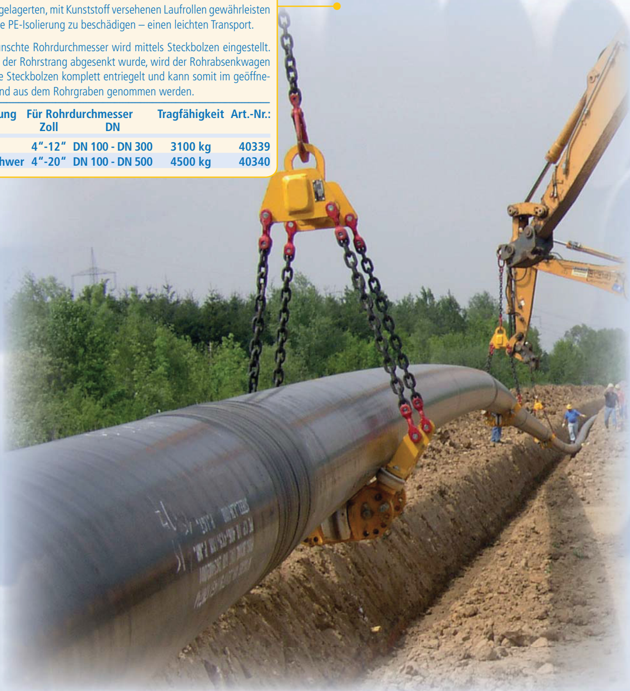
VIETZ Rohrabsenkwagen im Baustelleneinsatz bei unserem Kunden der Firma Josef Pfaffinger Bauunternehmung GmbH in Passau.
